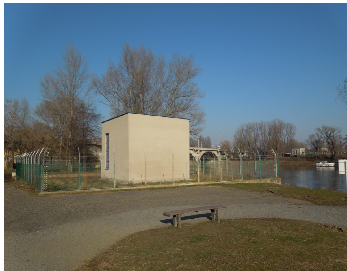
Obr. 75 Vpravo dole: V řešeném území poblíž Libeňského mostu se nachází oplocený objekt PVK a.s. (foto autor, 2013)
